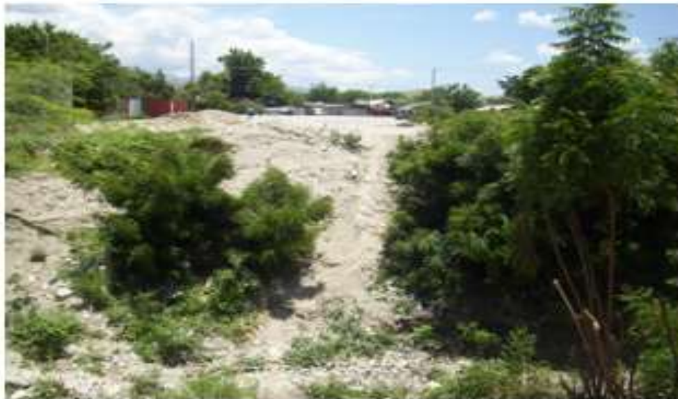
Existence d'un fossé séparant la route de contournement de la ville des Gonaïves à la Route Nationale # 1
