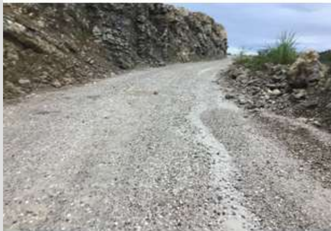
Photos : 1, 2 et 3 : Ouvrage de consolidation d'un passage étroit et zone à dynamiter pour élargir la voie
