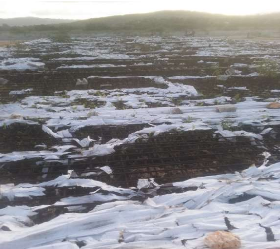
Socle pour l'installation du marché inachevé
