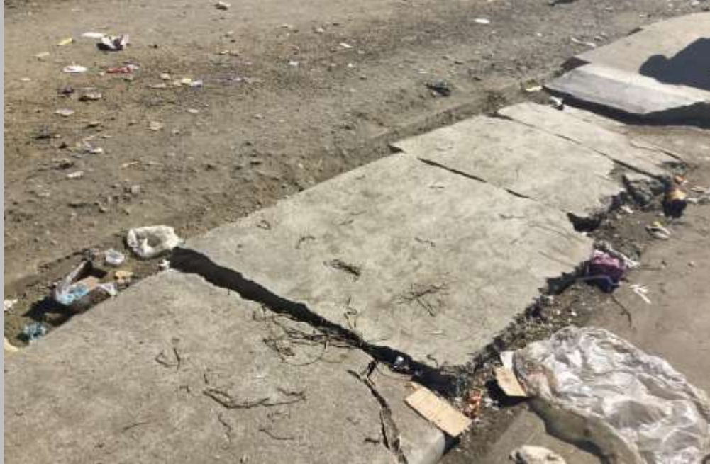
Rue CODEVI (trottoir) à Ouanaminthe
